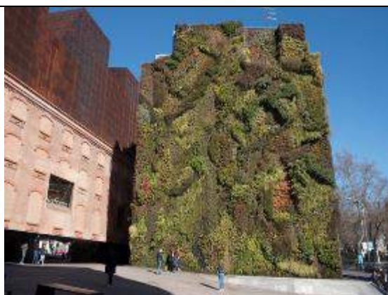
CaixaForum- Μαδρίτη, Κατασκευή:PatrickBlanc
