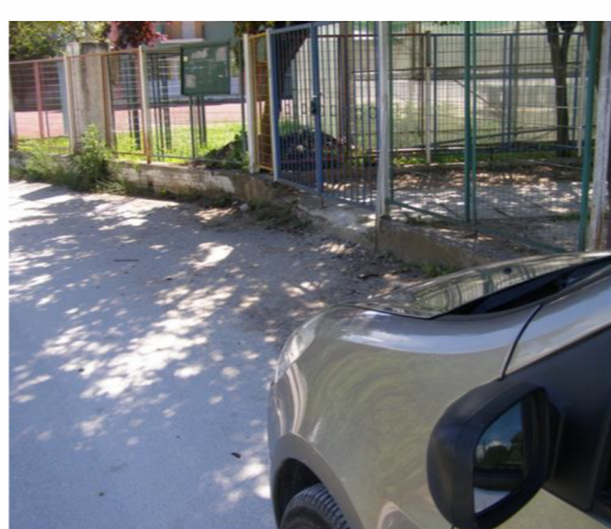
Figure 1 Απουσία ράμπας στην είσοδο του νηπιαγωγείου για πρόσβαση αναπήρων ατόμων
